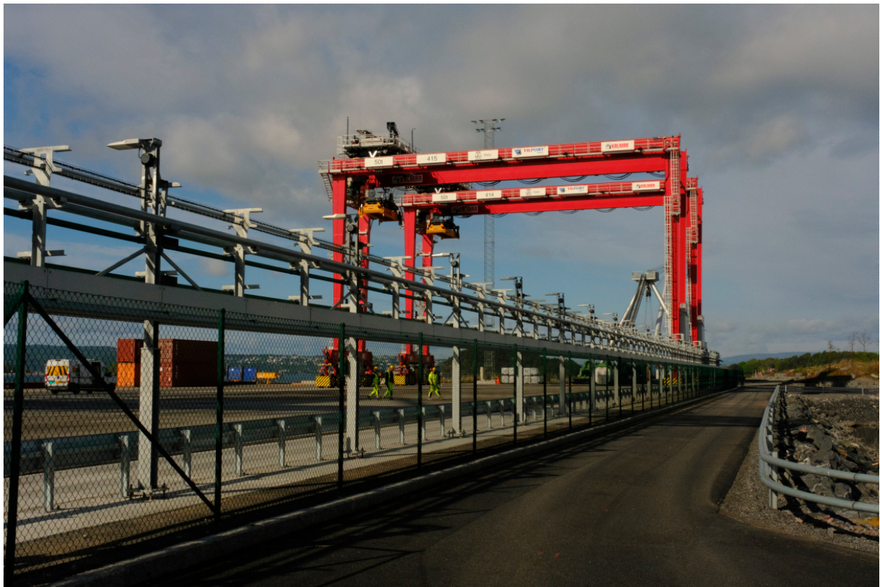
Ill. 1 Ferdigstilt Stack 3.1 med RTG-kraner og busbar mot vest
